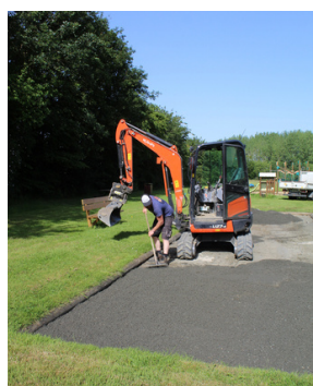
Réfection du boulodrome
