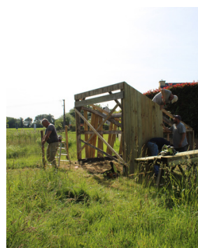
Bardage de l'abri à l'éco-pâturage
